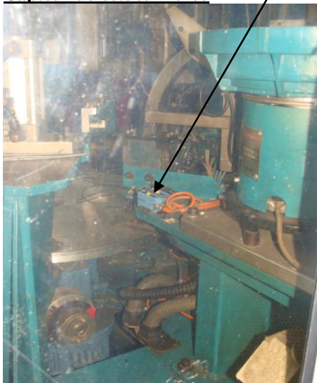
Capteur défectueux ferco
