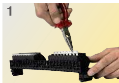
1 Retrait du peigne sur le bornier phase/neutre
