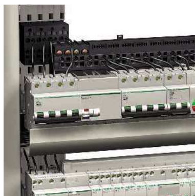
Un appareil "tête de groupe" alimente un répartiteur Multiclip 80 A
