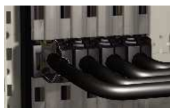
Capot clipsables pour isoler les cosses d'une liaison
