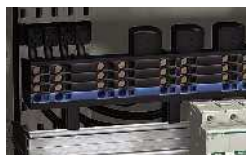
Liaison 200 A pour répartiteur Multiclip
