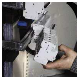
Répartiteur Multiclip alimenté par un appareil "tête de groupe"
