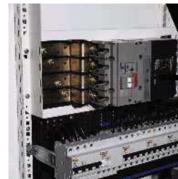
Tête de tableau raccordée au jeu de barres Powerclip par un bloc d'alimentation avec liaison
