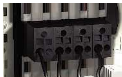
Bornes de dérivation pour câbles 6 et 10 mm 2
