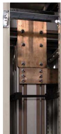
Liaison entre jeu de barre horizontaux et verticaux
