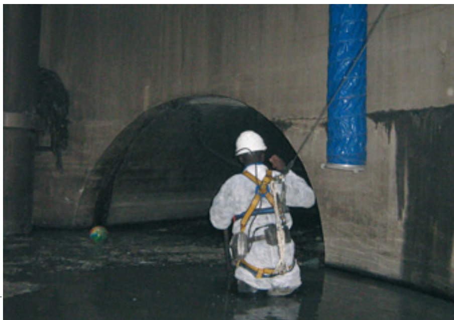
Opérateur sécurisé contre les risques de chute et d'entraînement
