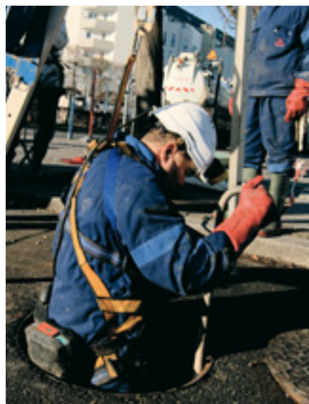
Sécurisation des entrées/sorties au moyen d'un système d'arrêt de chute
