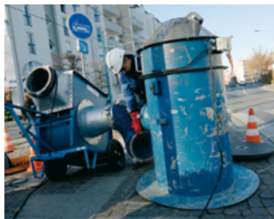
Mise en place d'une ventilation forcée sur une des ouvertures d'accès
