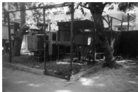
Fig. B34 : Poste d'extérieur sans enveloppe
