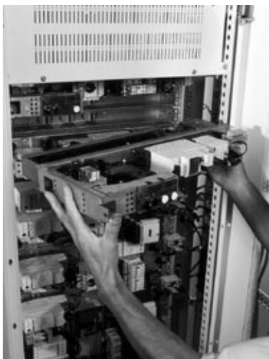
Fig. E32 : Tableau à unités fonctionnelles sectionnables-déconnectables
