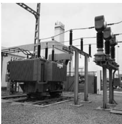
Fig. B23 : Transformateur respirant avec conservateur
